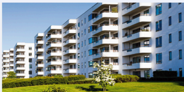
CONSTRUÇÃO DE CONDOMÍNIOS RESIDENCIAIS
