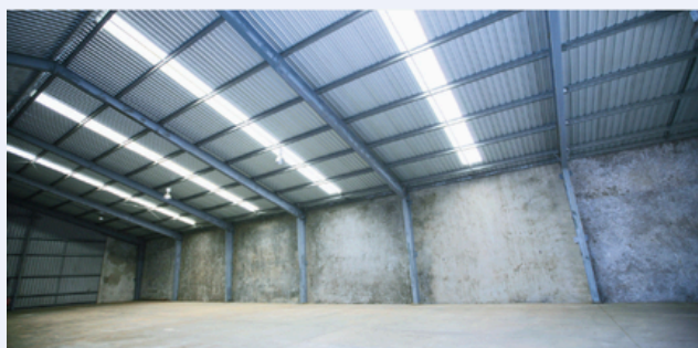
CONSTRUÇÃO DE GALPÕES EM GERAL
