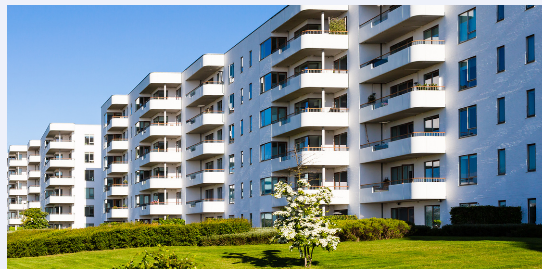
CONSTRUÇÃO DE CONDOMÍNIOS RESIDENCIAIS
