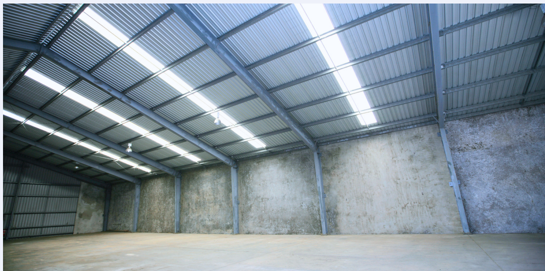
CONSTRUÇÃO DE GALPÕES EM GERAL
